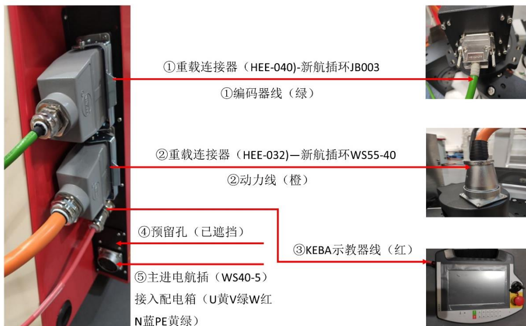
图 2.36 控制柜接线
